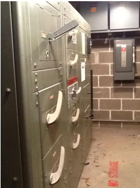
Existing 240 volt 3Ø Delta Gear
