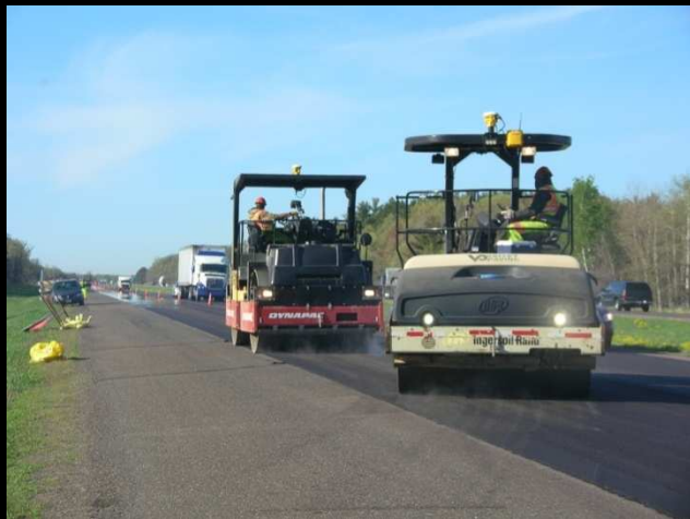
Retrofit IC Rollers
